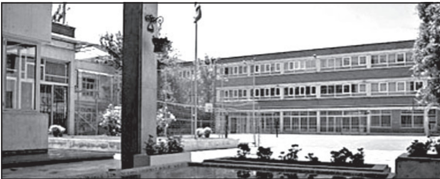
حیاط و ساختمان جدید مدرسه علوی تهران
